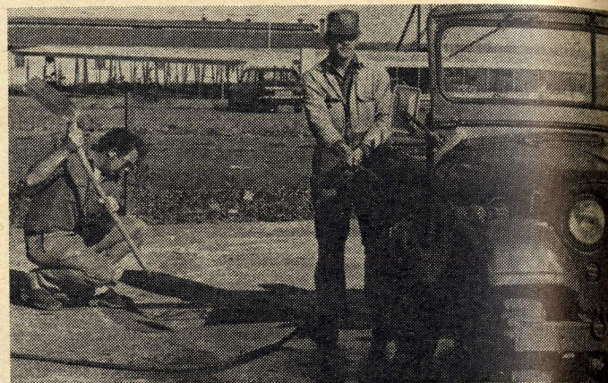
KS Christensen og Lønstrup, henholdsvis murer og smed, afprøver deres arbejde: Vaskepladsen!
