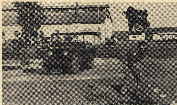
KS Ejner Christensen i gang med det sidste arbejde på vaskepladsen, som ligger ved motorpuljen i Viking Camp.
