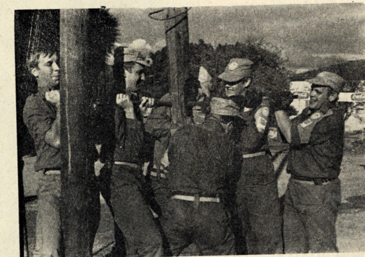
Viestimiehen työ vaatii joskus raakaa voimaa. Rankimpia puuhia on puhelinpylvään pystyttäminen ja joskus jopa kaataminenkin. Pylvään vaihto esikunnan portilla käynnissä.
